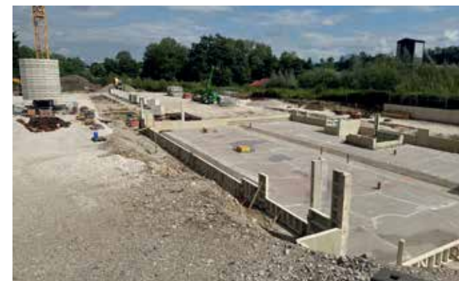
Rohbauphase im Sommer 2025
