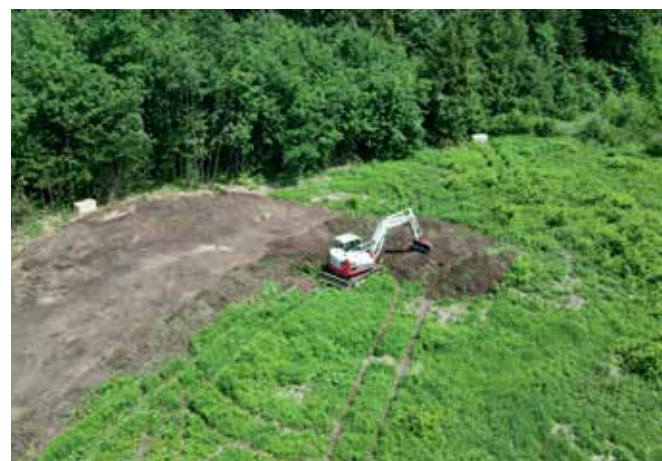
Der Bagger kommt (6. Juni 2025)
